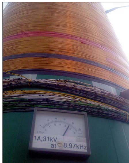
Ladespule auf einer Wassertonne bei DK7FC
